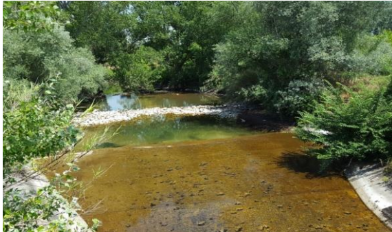
Σχήμα 14. Ροή κατάντη (απόμακρη) θυροφράγματος αρδευτικού αγωγού στην έξοδο προς την φυσική ροή του Νέστου ποταμού, 41° 00' 20.77''N, 24°43' 41.03''E, Περιφερειακή Ενότητα Καβάλας
