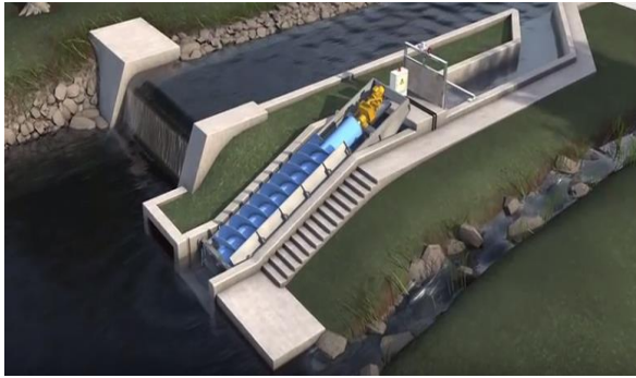
Σχήμα 2. Τυπική εγκατάσταση υδροστροβίλου τύπου Αρχιμήδους.
