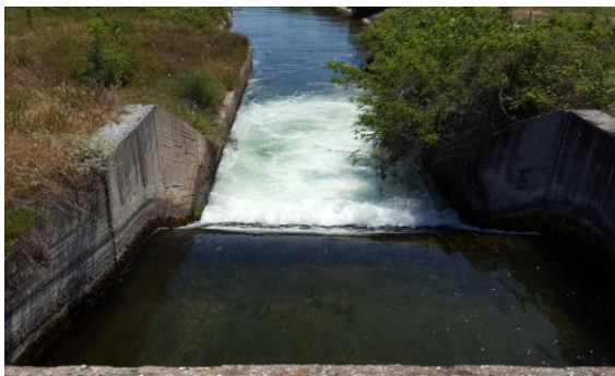
Σχήμα 13. Εκχειλιστής αρδευτικού αγωγού Νέστου ποταμού, κατόντη μΥΗΣ. Χρυσούπολη Καβάλας με 41^{\circ} 0' 25'' \text{N} , 24^{\circ} 43' 19'' \text{E} , Περιφερειακή Ενότητα Καβάλας.
