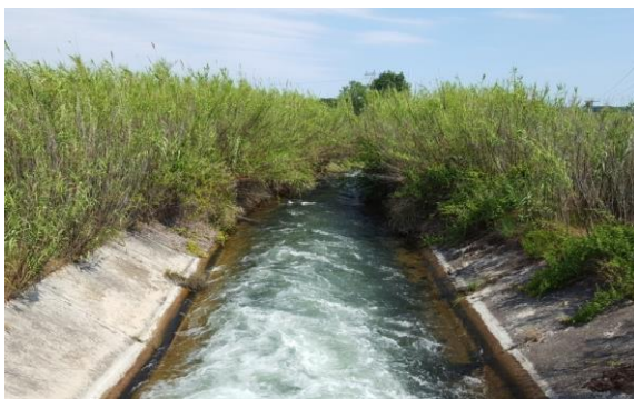
Σχήμα 15. Ροή κατάντη θυροφράγματος αρδευτικού αγωγού Νέστου ποταμού. Χρυσούπολη Καβάλας, 40° 59' 35.99''N, 24°43' 10.81''E, Περιφερειακή Ενότητα Καβάλας.
